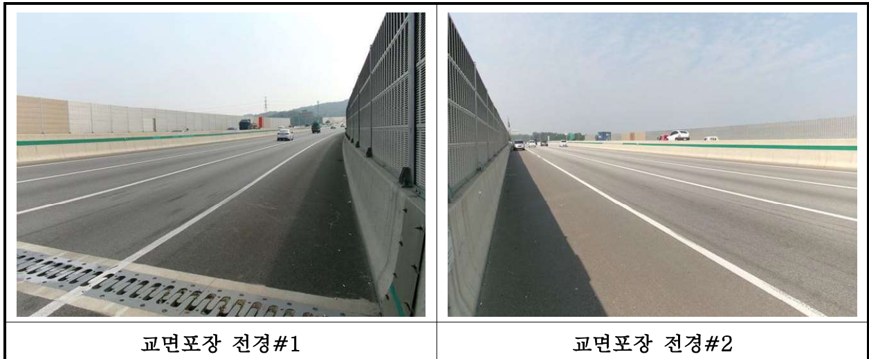
【사진 27.3.19】 교면포장 전경
