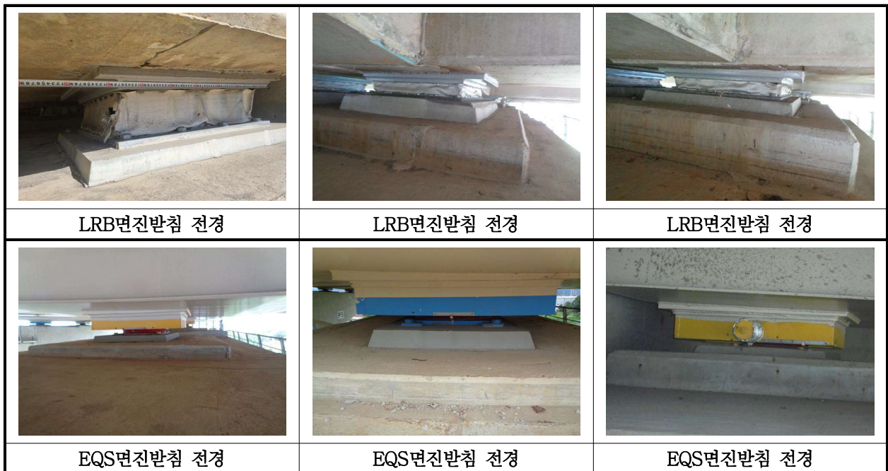
【사진 27.3.12】 교량받침 전경
