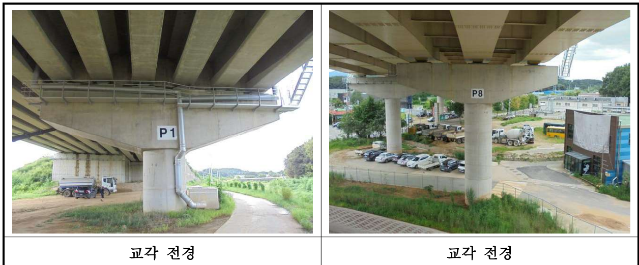
【사진 27.3.10】 교각 전경
