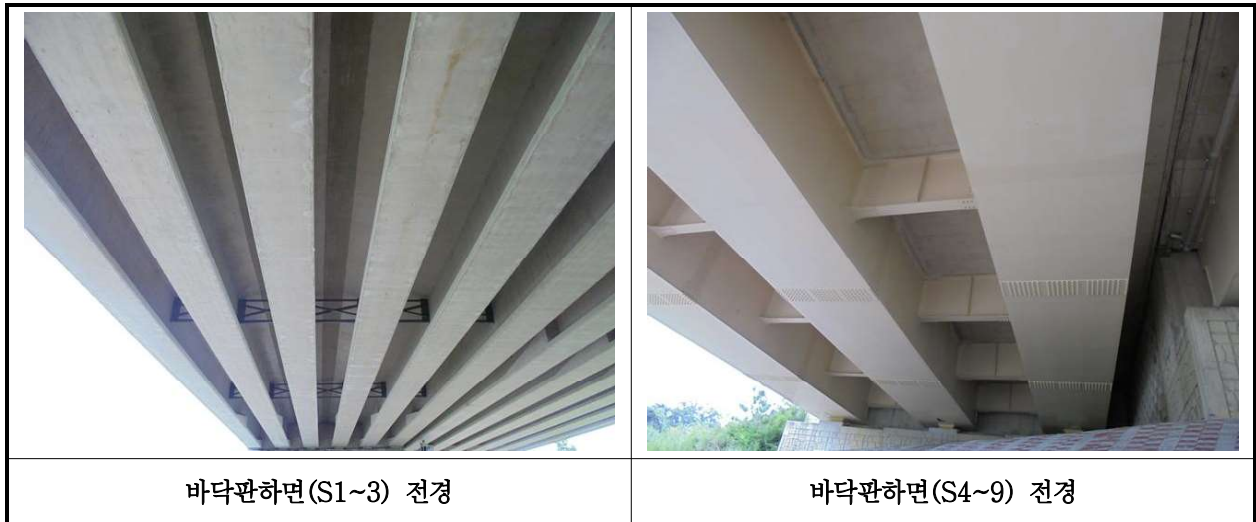
【사진 27.3.2】 바닥판하면 전경
