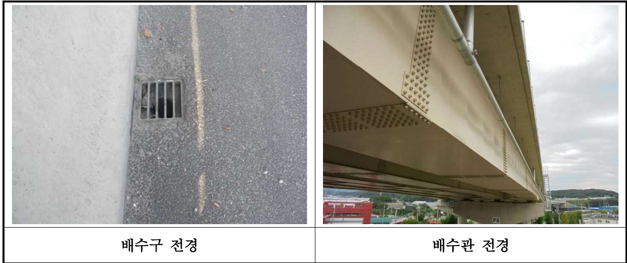
【사진 27.3.21】 배수시설 전경
