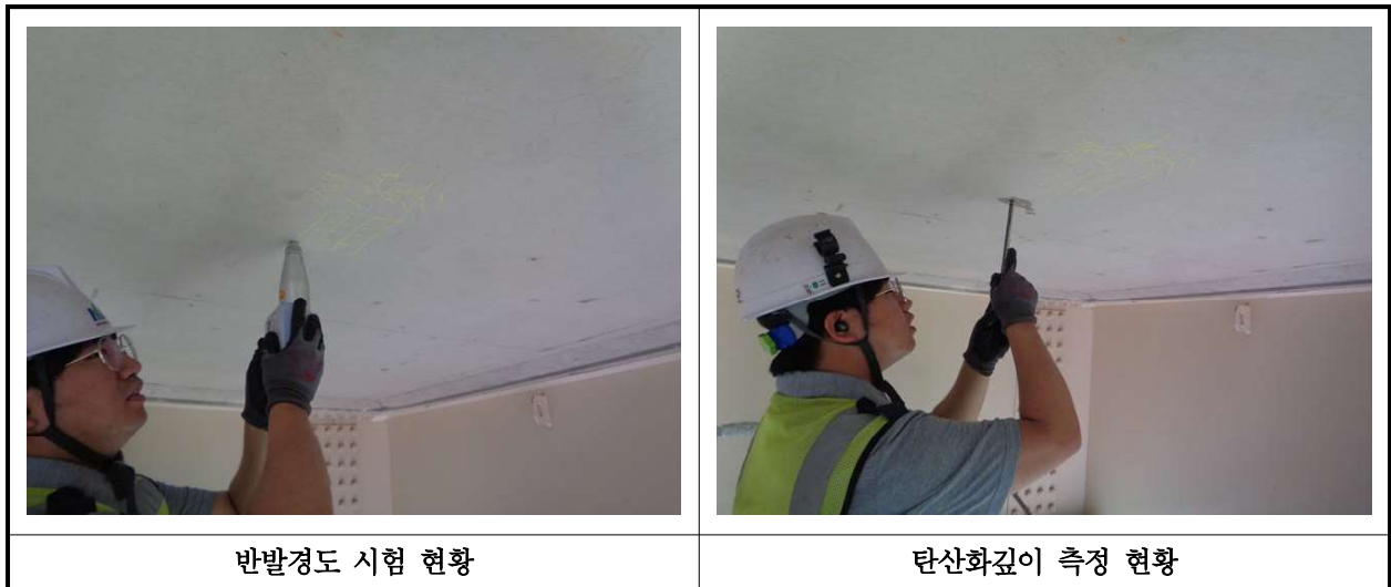
【사진 27.4.1】 콘크리트 내구성조사 현황
