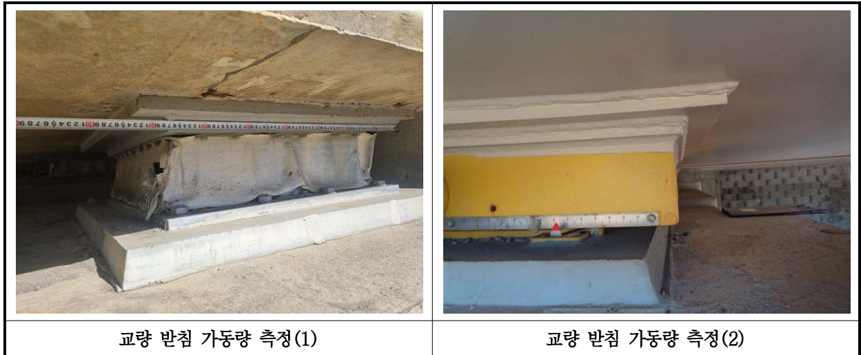
【사진 27.3.15】 교량받침 이동량 측정
