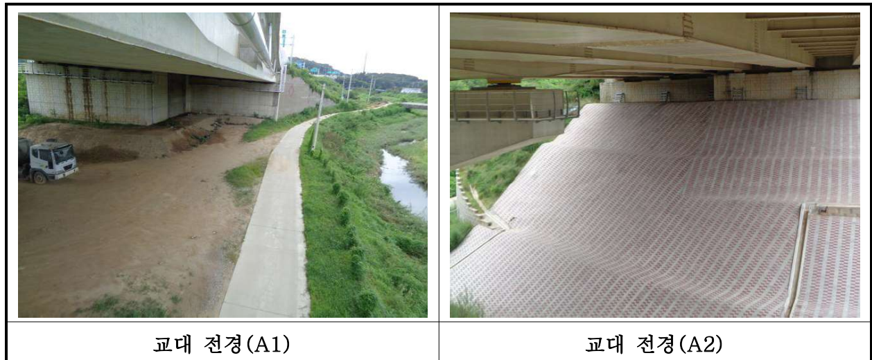
【사진 27.3.8】 교대 전경
