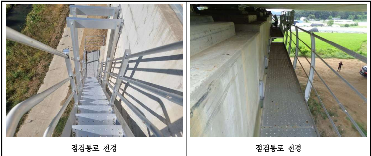
【사진 27.3.25】 교량 점검시설 전경
