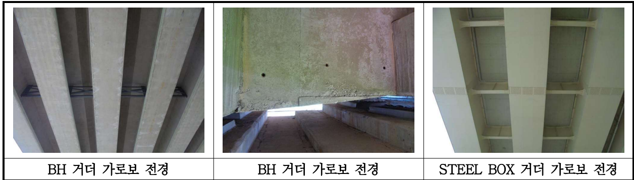
【사진 27.3.6】 가로보 전경
